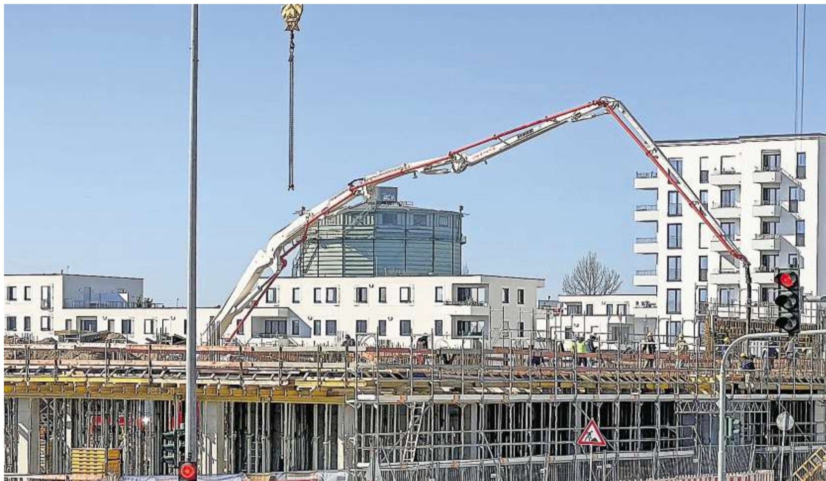
Im Candisviertel hat der Bau der Büroriegel an der Straubinger Straße begonnen.
