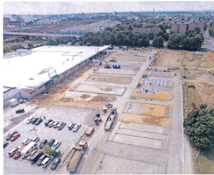
An der Römerstraße ist noch eine große Baustelle. Dort entsteht das neue Einkaufszentrum. Die Erneuerung der kompletten Dachfläche ist bereits abgeschlossen.
